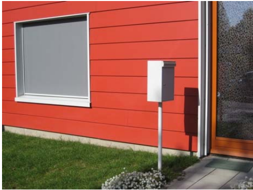
Figuur 5: Buitenzonwering in de vorm van handmatig te bedienen screens is voorzien in vrijwel alle ramen en deuren
