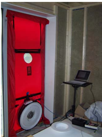
Figuur 9: Blowerdoortest, uitgevoerd door b/e Visie, ten behoeve van metingen luchtdichting
